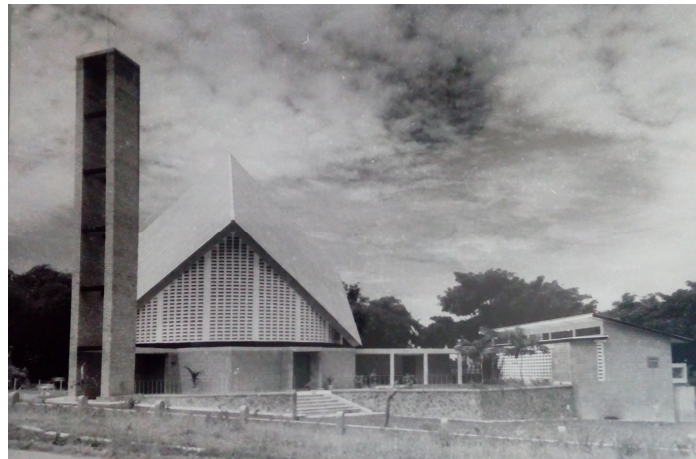
Fig 5. Foto della Chiesa di San Luca a Kinshasa, 1963 [Foto Archivio KADOK di Kinshasa]
